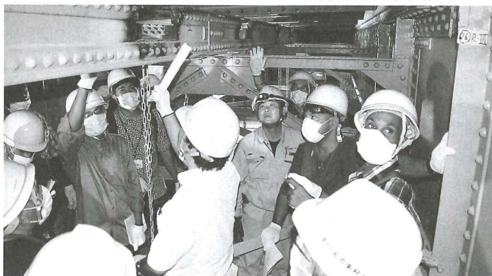
9日には泊高橋の現場視察も行われた
