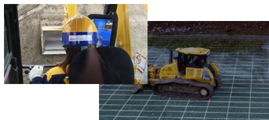
ICT建機による施工
