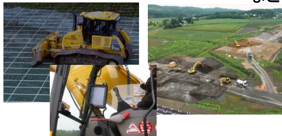
ICT建機での施工
