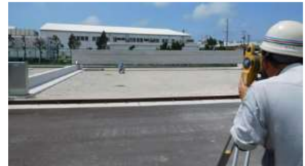
各ポイントの測量状況
