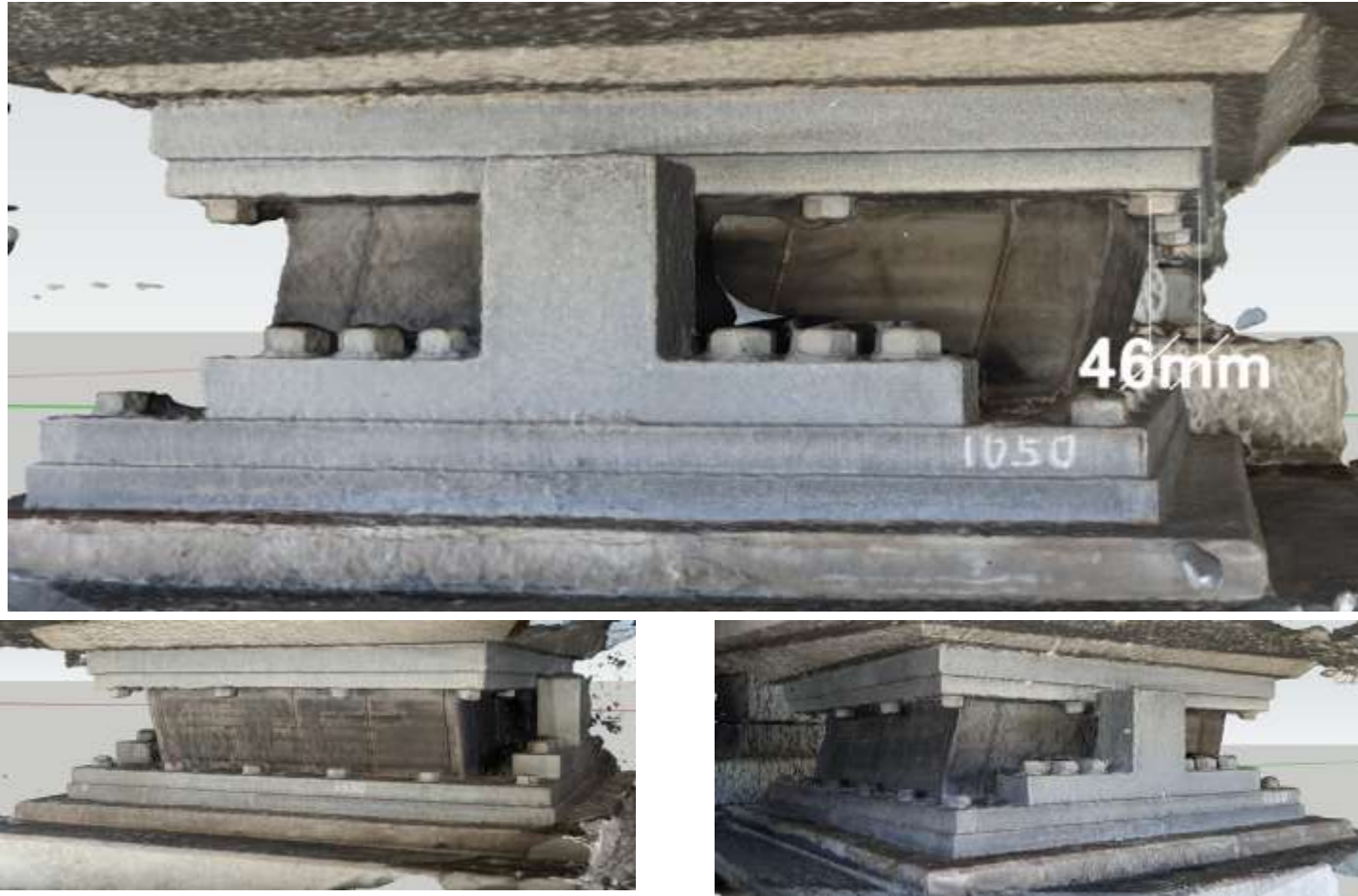
SketchUpにインポートした支承の3Dモデル
