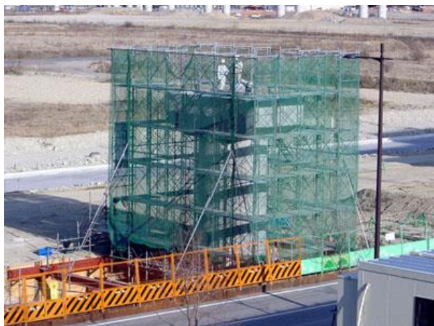
図-10 足場設置による橋脚の座標測量
