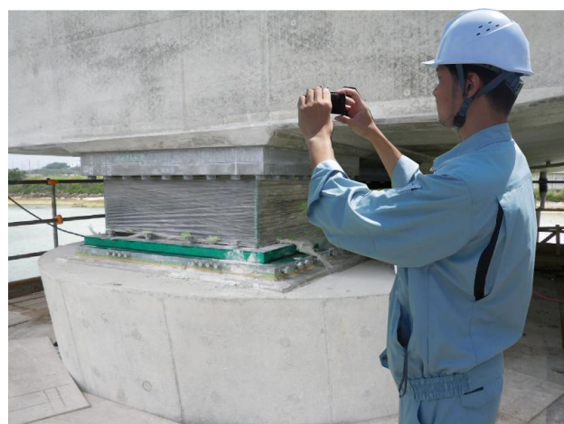
図-15 デジカメ撮影による支承変位調査イメージ
