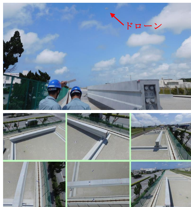
図-2 ドローン空撮状況と空撮写真(抜粋)
