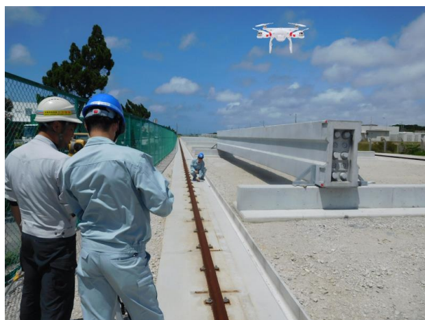
図-13 ドローン空撮によるキャンバー管理測量イメージ
