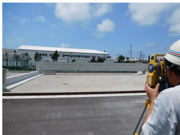
図-12 PC桁のキャンバー管理測量
