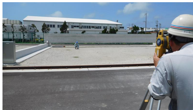
図-4 各ポイントの測量状況
